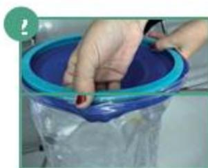
2 Eleve o conjunto membrana de silicone / anel interno até a altura equivalente à borda nal da cápsula de PVC. É fundamental que o conjunto membrana de silicone / anel interno esteja completamente alinhado e plano com a borda da cápsula de PVC conforme foto.
